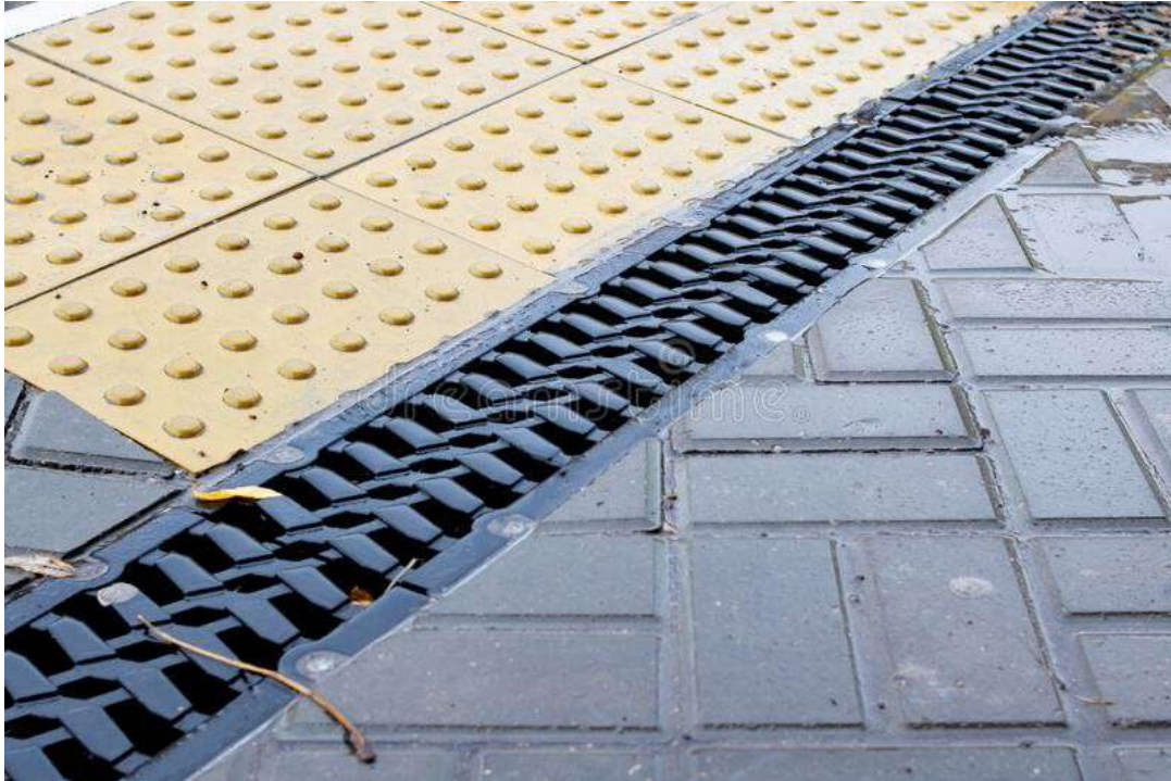
Εικόνα 3: Τοποθέτηση σχαρών στο πεζοδρόμιο (πηγή: https://es.dreamstime.com/ )
