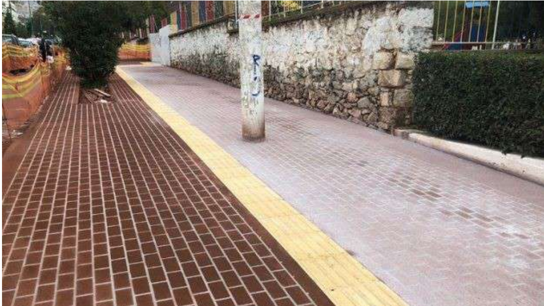
Εικόνα 2: Σταθερό, συνεχές και επιμελές αρμολόγημα (πηγή: https://www.michanikos-online.gr/ )
